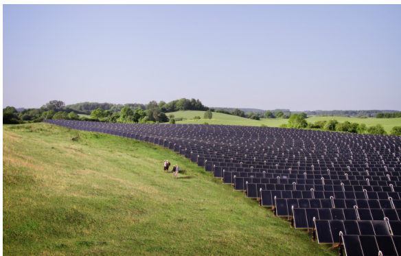
Fyns største solvarmeanlæg ligger i Tommerupperne og giver os CO 2 -neutral fjernvarme. Anlægget fylder 8 ha og forsyner begge byer med varme.
